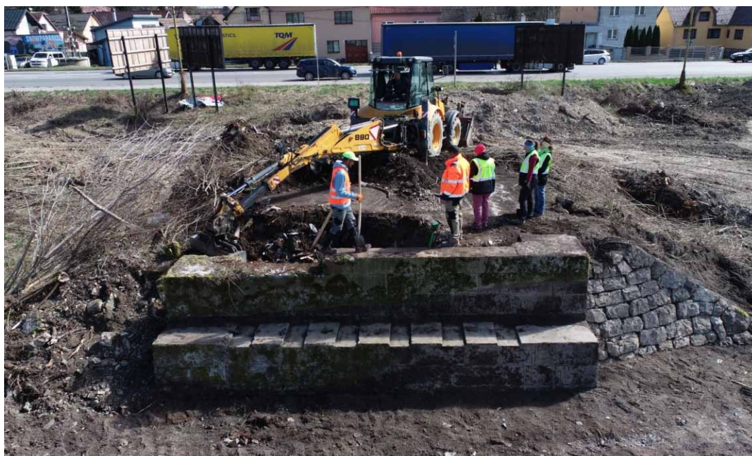
Odkrytá podpera mosta na radoľskej strane (Foto: Archeo Sever)
